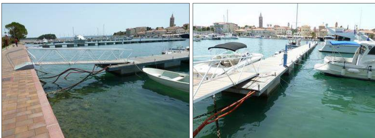
Slika 2.1-10. i slika 2.1-11. Prikaz konstrukcije pontonskih gatova „A“ - „D“ izvedenih od plutajućih sanduka povezanih međusobno sidrenim lancima dijelom i za obalu
